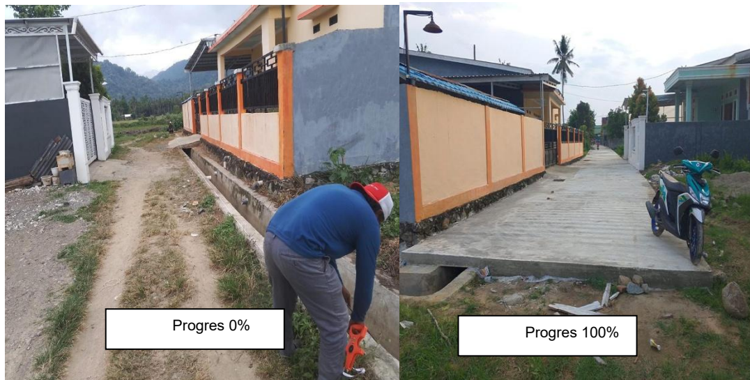
Gambar 4. Kegiatan Pembangunan Jalan
