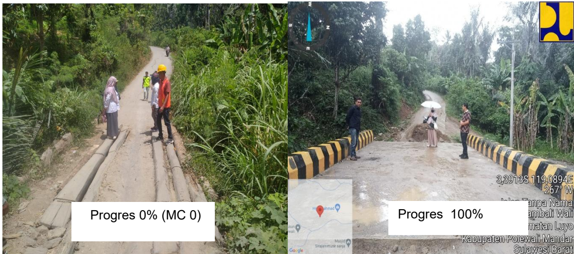
Gambar 6. Dokumentasi Kegiatan Pembangunan Jembatan
