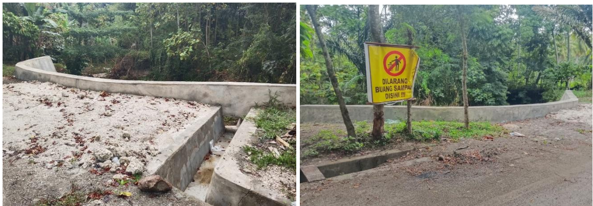
Dokumentasi Pembangunan Talud di Lingkungan Paayuman Kelurahan Balanipa Kecamatan Balanipa
